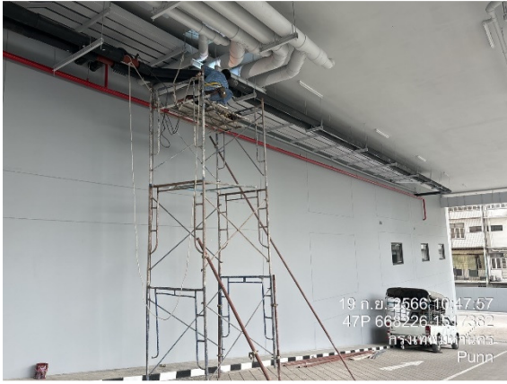
ภาพที่ 36 ใช้นั่งร้านตามมาตรฐานขณะทำงานบนที่สูง
